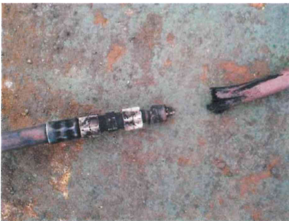
Mangueras dañadas después de un incendio
